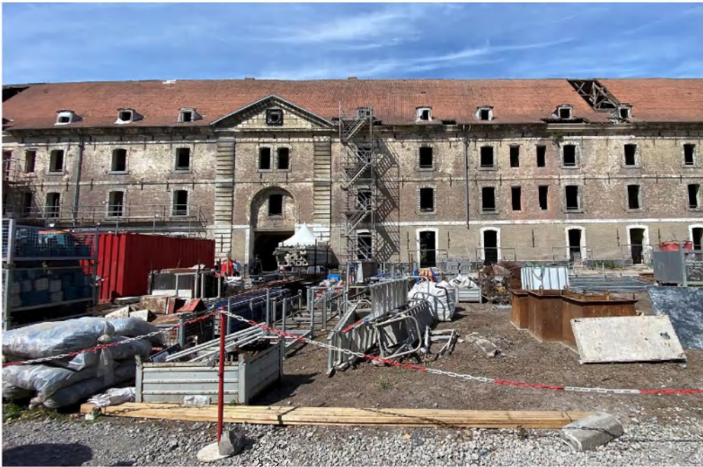
Le chantier de l'aile ouest de la caserne Caux avance au rythme prévu. Les 123 logements devraient être livrés à l'été 2023.
